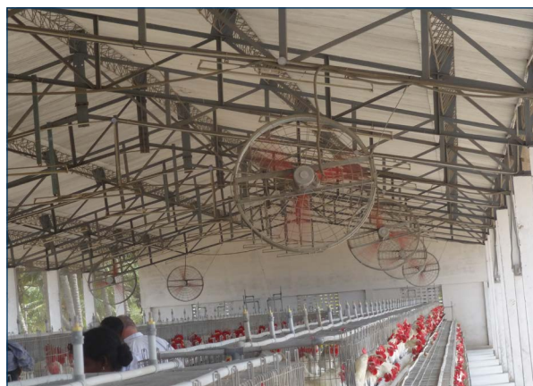
Рисунок 4. Вентиляторы и аэрозольное орошение увеличивают скорость воздуха внутри птичника и создают охлаждающий эффект.
