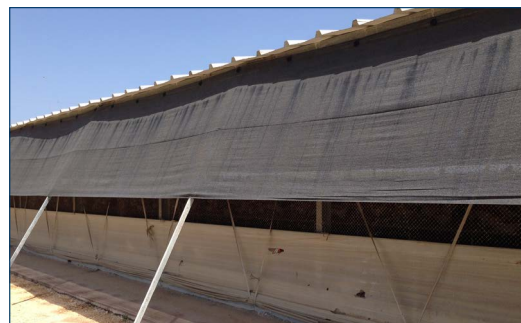
Рисунок 9. Пористые оконные шторы блокируют прямой солнечный свет от попадания в птичник, но позволяют проходить воздуху.
